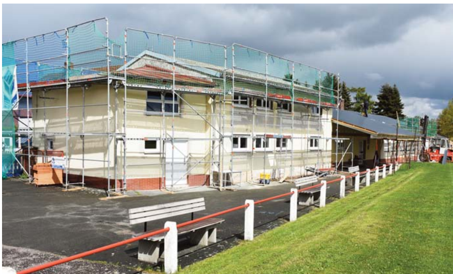
Mehr Bauarbeiter als Sportler sind aktuell am Sportheim des TSV.
