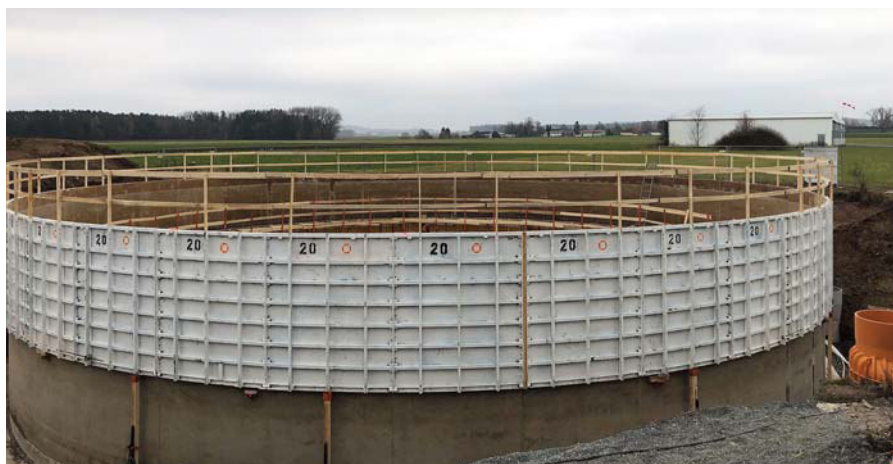
Die Arbeiten an der neuen Kläranlage kommen gut voran.
