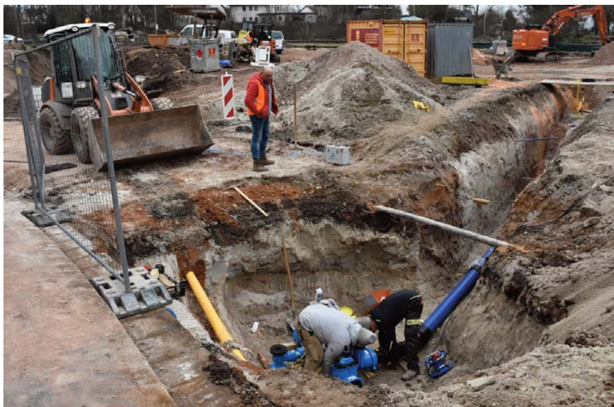
Weitgehend abgeschlossen ist die Verlegung der Versorgungsleitungen.
