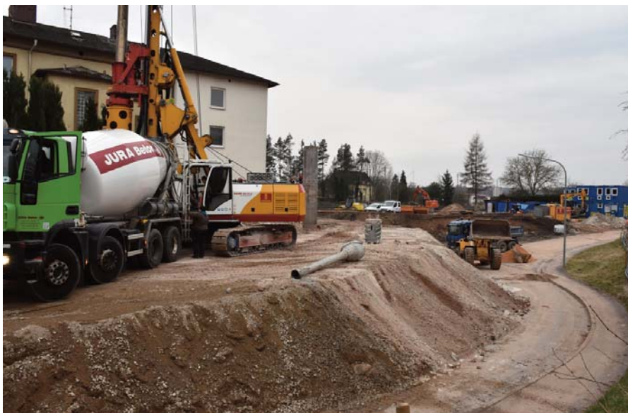
Von einer eigens angelegten Behelfsstraße aus werden die Bohrpfähle für die neue Böschung eingebaut.
