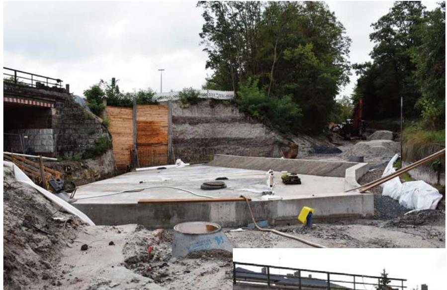
*Der Kreuzungsbereich auf der Südseite entsteht derzeit mit einer betonierten Grundwasserwanne. Der Höhenunterschied zwischen neuer und alter Straße ist gut zu erkennen (kleines Bild)*
