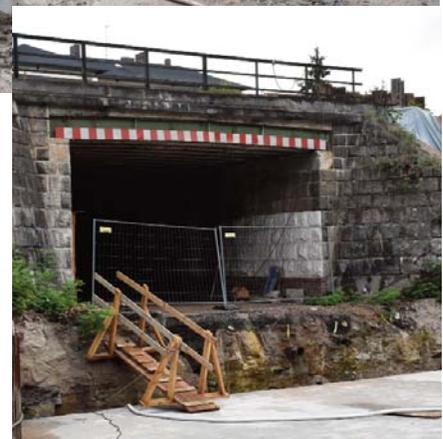
umfangliche Berichterstattung im Gemeindebrief vom Januar 2022. Das anfallende Wasser aus dem Unterführungsbereich muss mittels eines neuen Kanals und einem neu zu errichtenden Pumpwerk abgeleitet werden. Zusammen mit dem Brückenbauwerk
