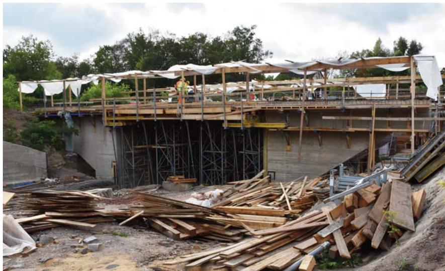
*Weitgehend fertig gestellt ist die neue Brücke, die Ende Oktober eingeschoben wird. Vorher wird die alte Brücke abgerissen.*
