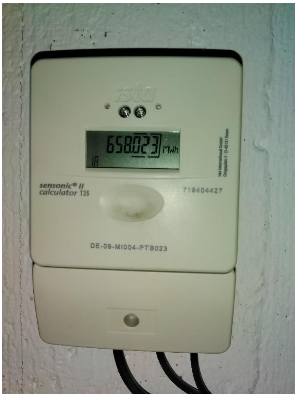
Abbildung 58: Verteilerraum Wärmemengenzähler
