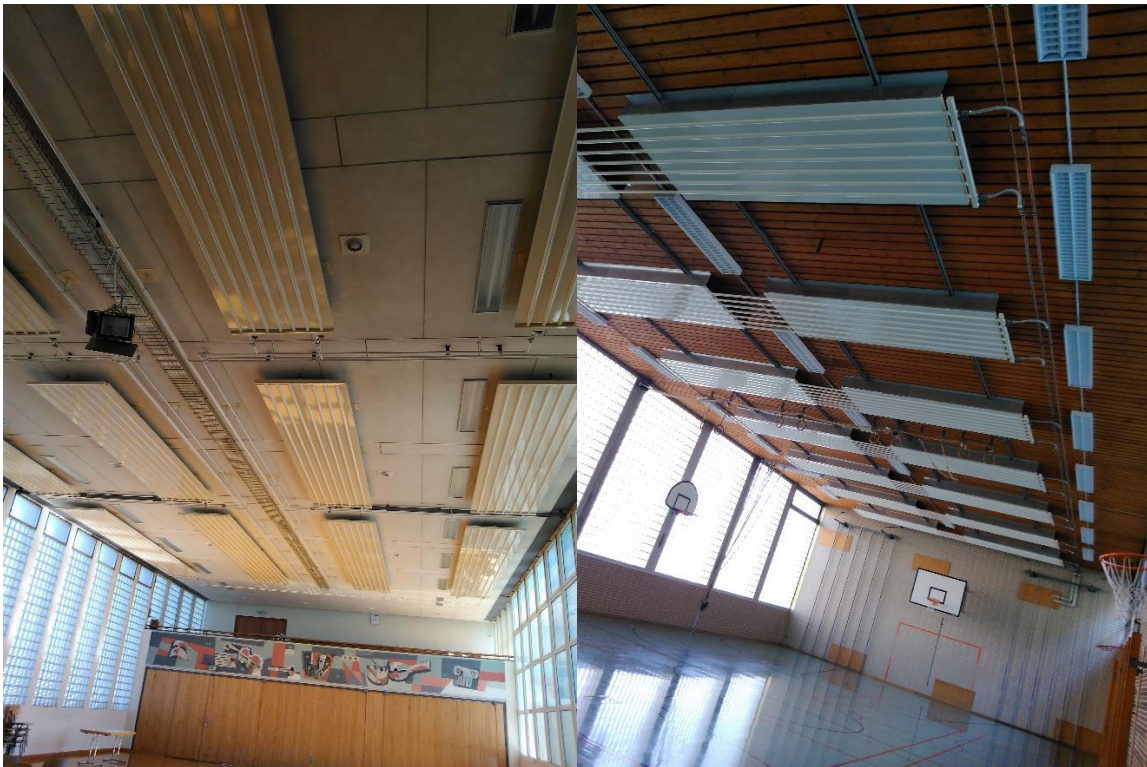
Abbildung 63: Deckenheizung
