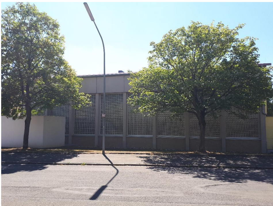
Abbildung 44: Ansicht Nord Halle West
