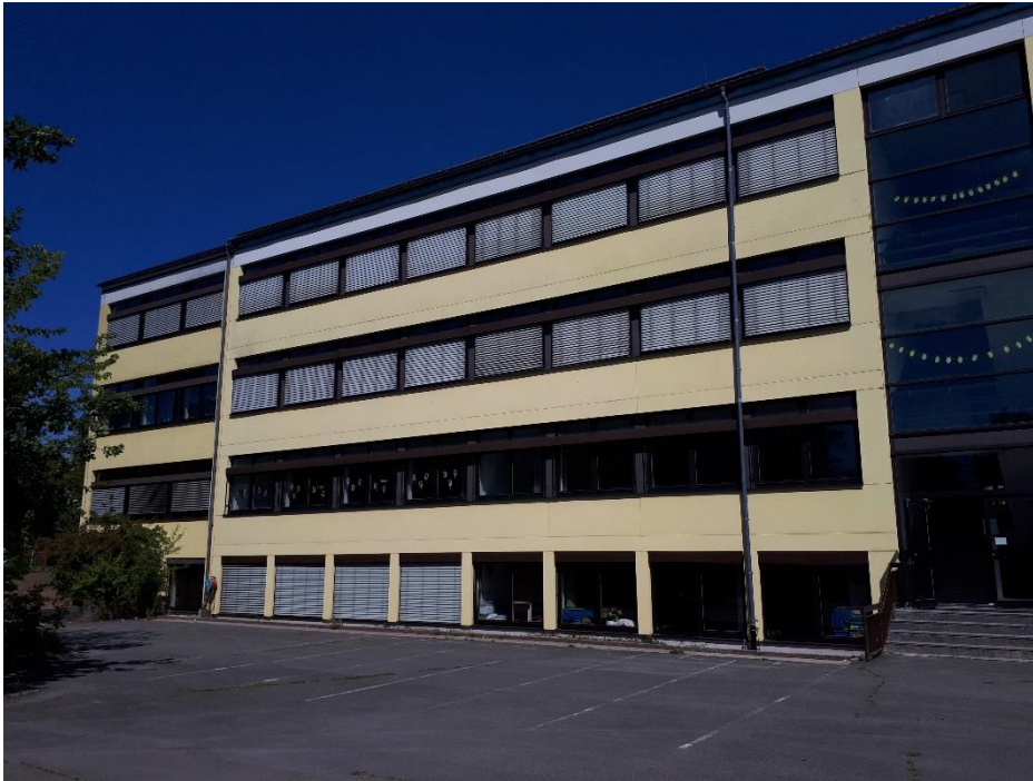
Abbildung 45: Ansicht Süd Grundschule
