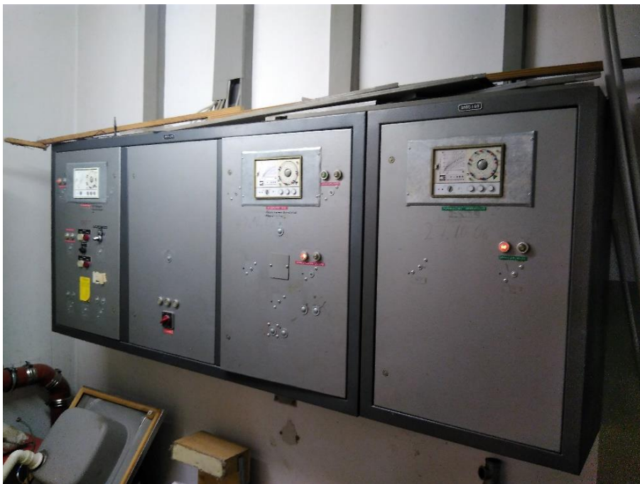
Abbildung 59: Heizungsregelung
