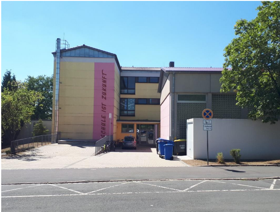
Abbildung 43: Haupteingang Grundschule Ansicht Nord
