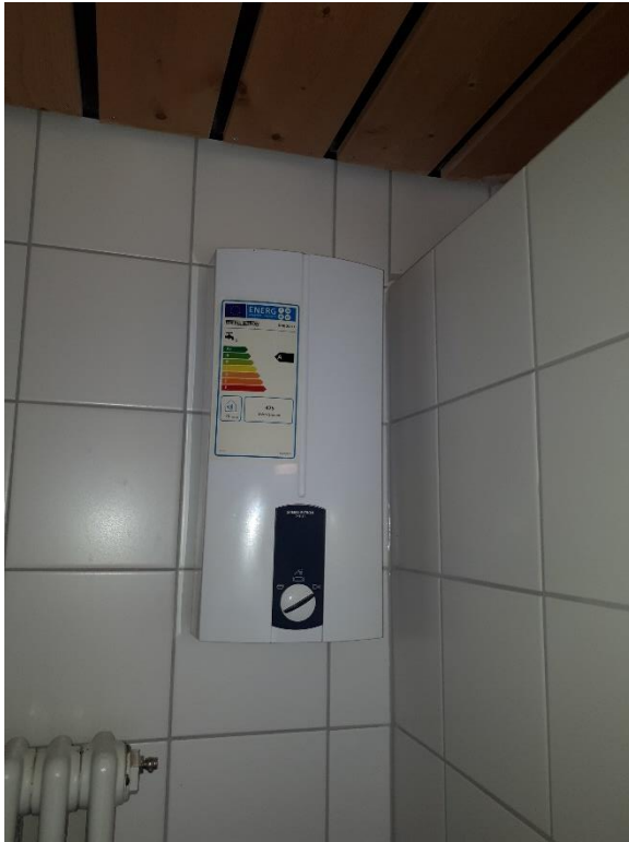
Abbildung 64: Warmwasser-Durchlauferhitzer
