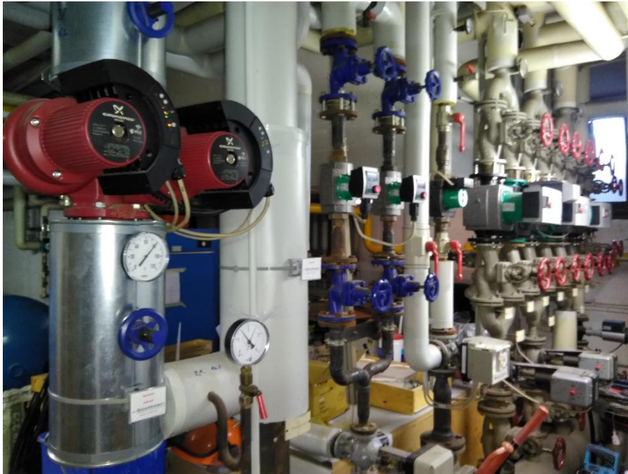
Abbildung 60: Haupt- Heizkreisverteilung
