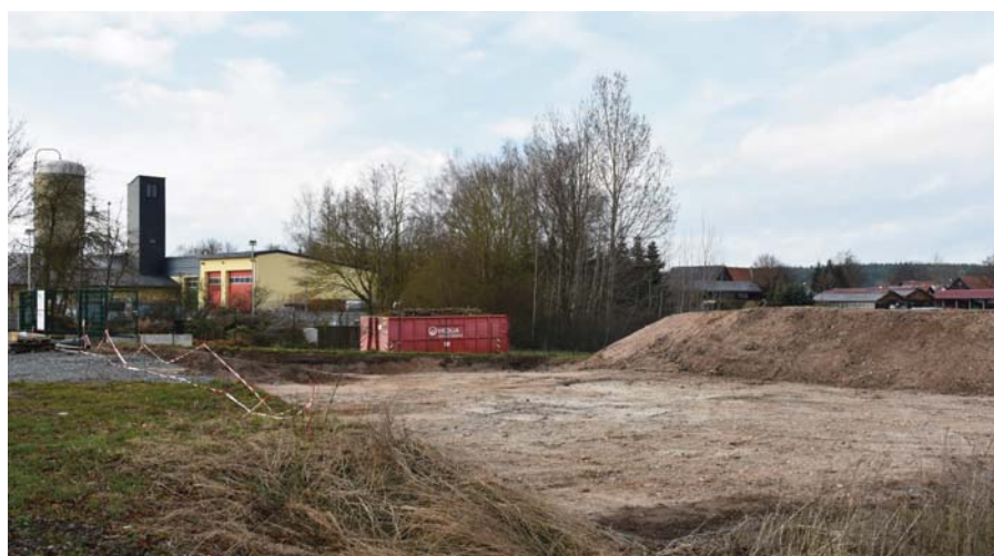
Laufende Vorbereitungen: Hinter dem Feuerwehrhaus entsteht eine neue Halle für den Bauhof.
