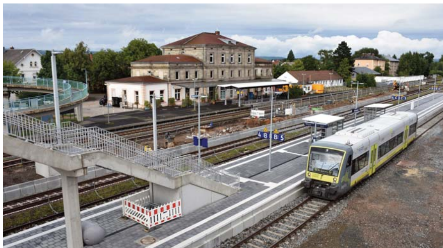
Gut voran kommt der barrierefreie Ausbau des Bahnhofs.
