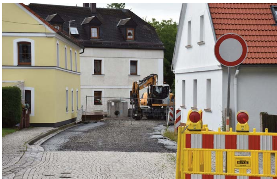
Die Kanalarbeiten in der Bayreuther Straße sollen in diesem Jahr abgeschlossen werden.
