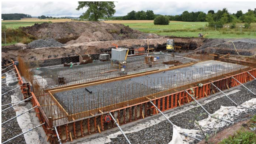
Für die Nahwärmezentrale wird aktuell die Bodenplatte erstellt.
